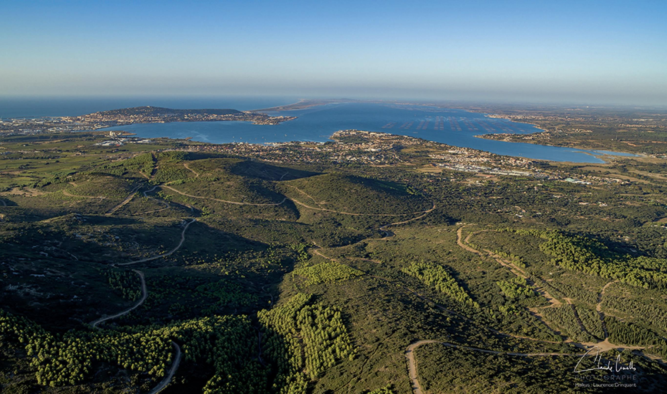
Vue nord du Bassin de Thau du Massif de La Gardiole
